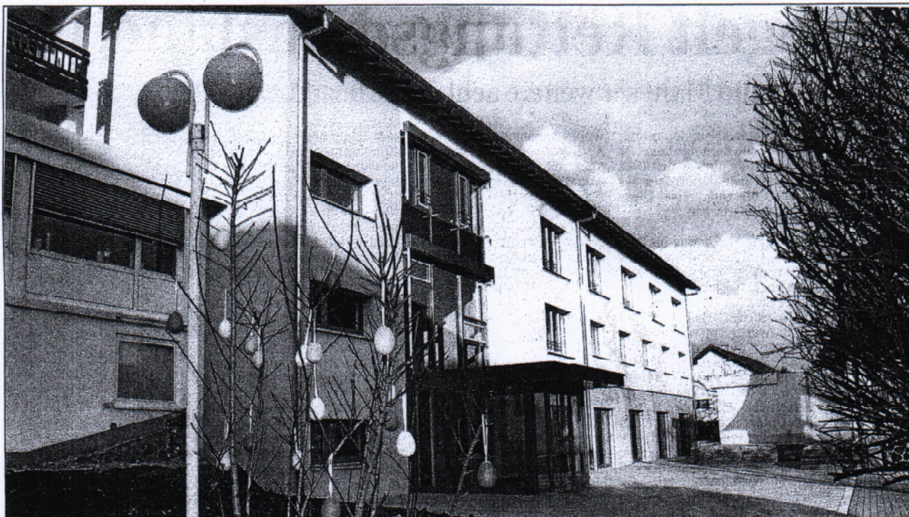
Den neuen Anbau wird die Hessische Berglandklinik ab Ostern beziehen. (Fotos: Meistrell)
